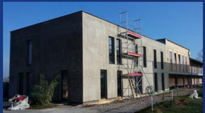
Rozestavěná budova SK Dolní Měcholupy
